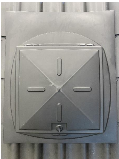
Kuva 7. Kattoluukku asennettuna
