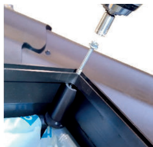
Kuva 3. Kattoluukun kiinnitys pohjaosaan.
