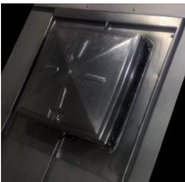
g. Kattoluukku asennettuna
