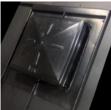
g. Kattoluukku asennettuna
