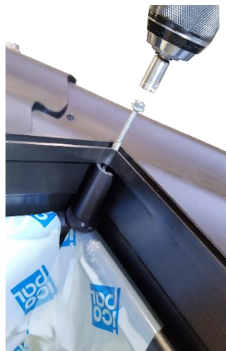
f. Kattoluukun kiinnitys pohjaosaan
