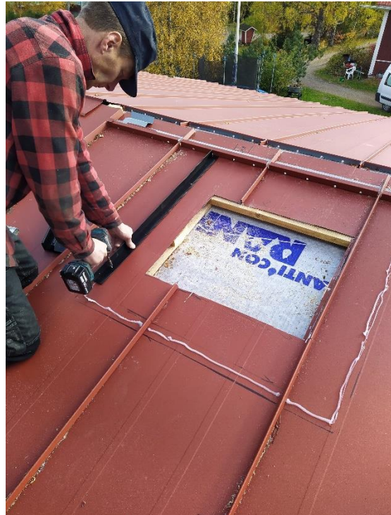
Kuva 2. listan kiinnitys katteeseen
